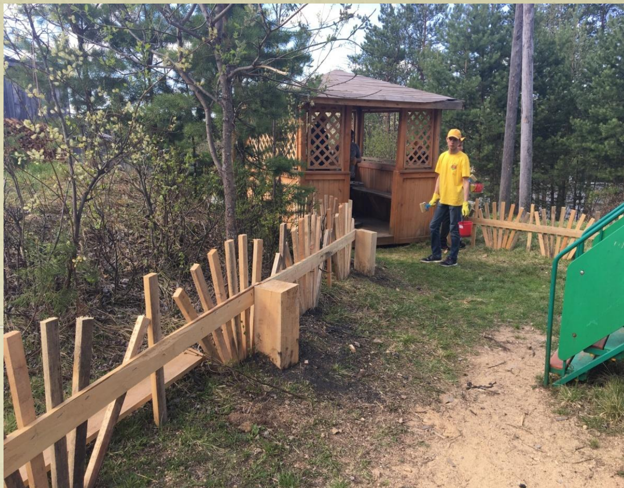
Установка ограждения детской площадки ТОС «Лесная сказка» в поселке Новая Калами
