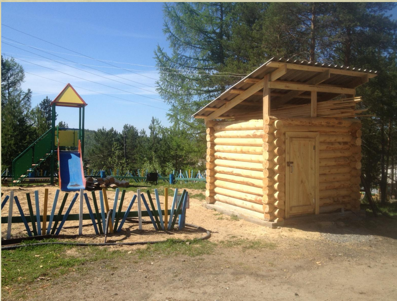
Новая водозаборная колонка ТОС «Лесная сказка» в поселке Новая Калами
