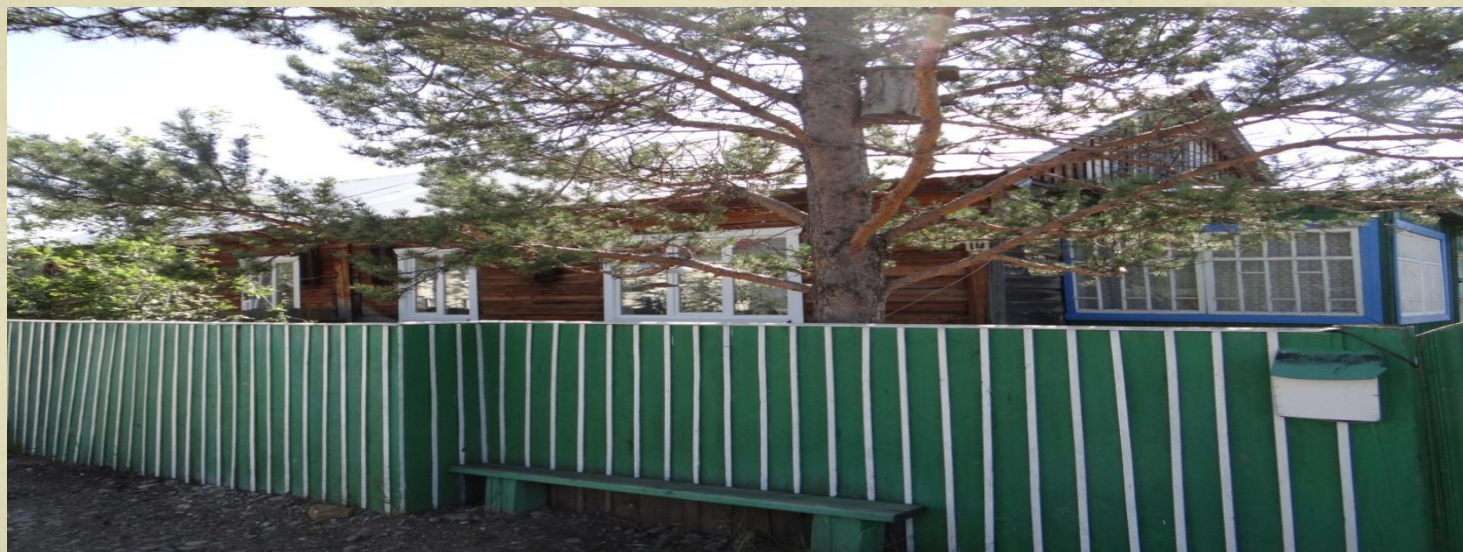
Отремонтированные заборы по ул. Советская, ТОС «Советский» в поселке Новая Калами
